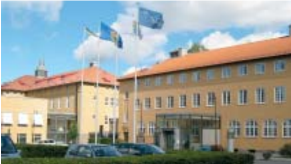
Vid utgången av året disponerade Åklagarmyndigheten en total lokal- yta på 37 039 kvadratmeter. Bilden visar den fastighet där Åklagar- kammaren i Linköping har sina lokaler.
